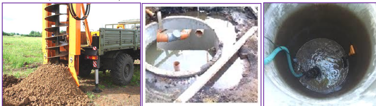
Рис.2.6,3.6,4.6 - Фото автора: бурение и монтажные работы по установке обсадной асбоцементной трубы и оборудования на оголовке запорной арматуры с системой поплавковых клапанов для обеспечения автоматизированной и фиксированной водоподачи в инфильтметр мини-бассейна
